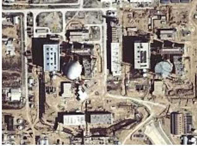
صورة رقم (1): صورة التقطت من طرف قمر اصطناعي تظهر تطور سير الأشغال في مفاعل بوشهر جنوب إيران عام 2002. المصدر: www.swissinfo.ch
