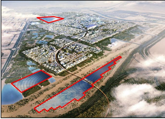
Fig. 13. Des fermes photovoltaïques qui produisent l'énergie pour la ville de Masdar [15].
