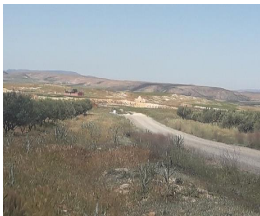
Photos 3 : réalisation d'une piste dans la commune d'El Bouihi
