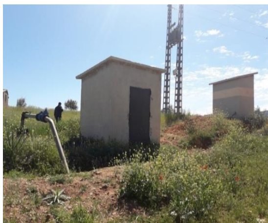
Photo 1 : réalisation d'un forage dans la commune de Sebdu
