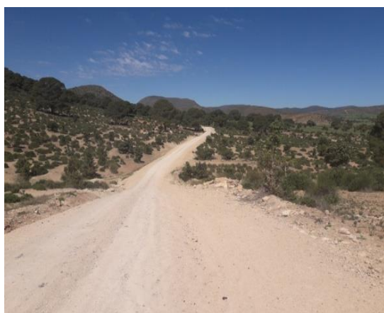
Photo 5 : réalisation d'une piste dans la commune de Sidi Djillali
