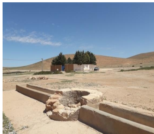
Photo 2 : réalisation d'un forage dans la commune d'El Aricha
