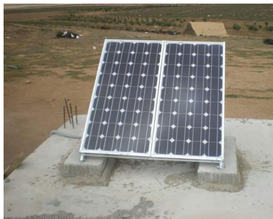
Photo 8 : mise en place d'un kit solaire dans la commune d'El
