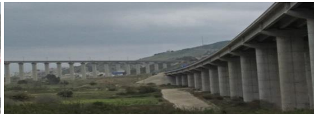
الصورة رقم 10: تجهيزات البنية التحتية
