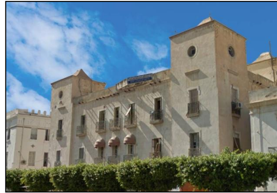
مبنى سكني، شارع فرحات حشاد: الواجهة الرئيسية (تصوير المؤلف)
