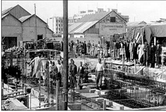
مارس 1946: أعمال إعادة البناء بنهج Mattéi (نهرج محمد علي حاليا)
