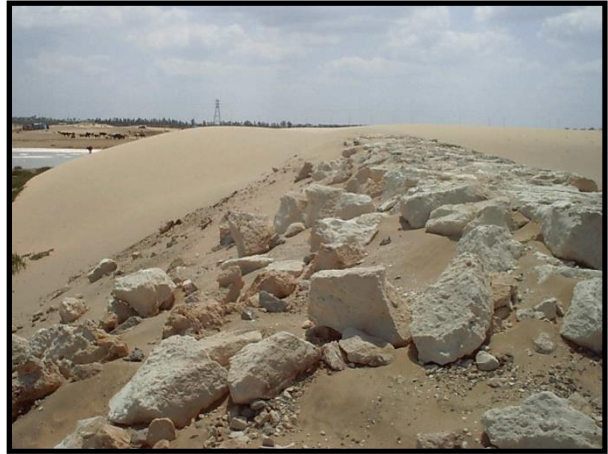
صورة (1) فشل الحاجز الصخري في زحف الرمال جنوب جمصة صورة (2) تجدد المياه في سبخات جنوب جمصة
