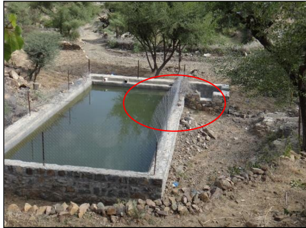
صورة رقم (1): خزان مياه الاسبل بالمواسط وفيه حماية من السلك قام بها المستفيدين، كما يظهر تهدم عند منطقة المشن بسبب قوة السيول
