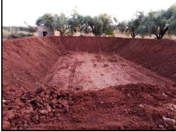
صورة رقم 6: صهريج لتجميع مياه بئر في طور الإنجاز
