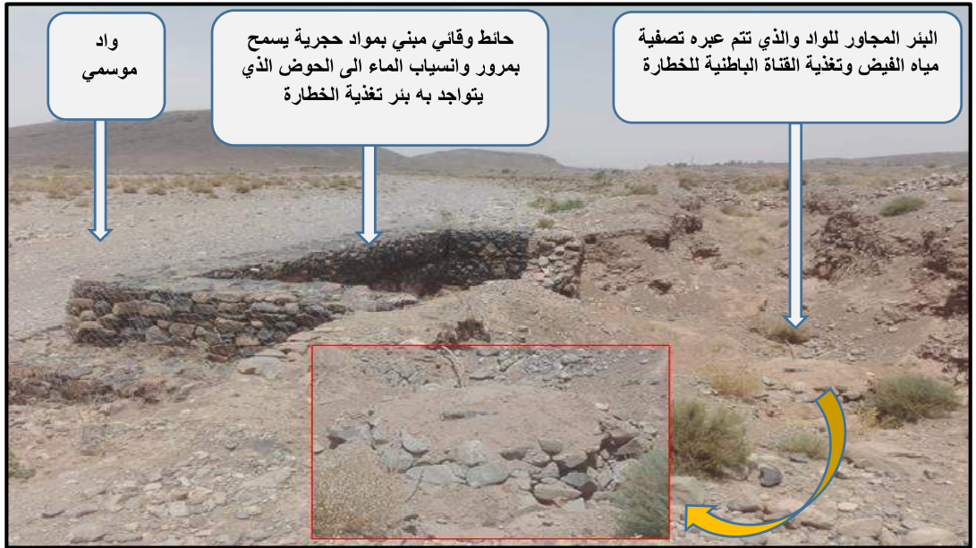
شكل رقم 4: طريقة تغذية خطارة قصر تاغيا بواحة فركلة من الواد
