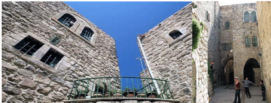
الصورة (4): الواجهات الخارجية للمباني السكنية ( https://info.wafa.ps/ar_page.aspx?id=10802 )
