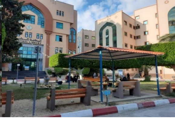
صورة 13، مبنى الإدارة ومبنى المكتبة المركزية. (الباحثة،2022).
