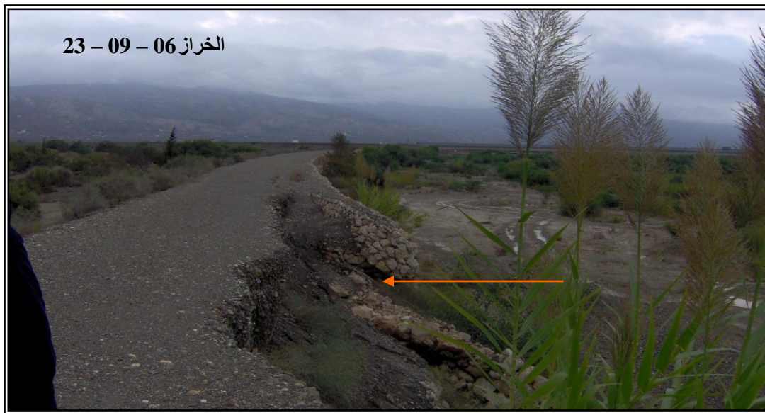
صورة (4-3) تحطيم تعرضت له حواجز على واد نكور نتيجة تقدم البحر وضعف الحمولة الرسوبية له.
