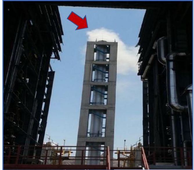
صورة (B.): في حالة عدم تشغيل تقنية المرسبات الالكتروستاتيكية تظهر سحباً من الانبعاثات
