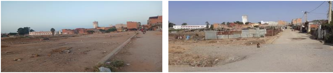
الصورة رقم 2: المنطقة الفيضية قبل وبعد الهدم، (المصدر: عمل ميداني 2024).
