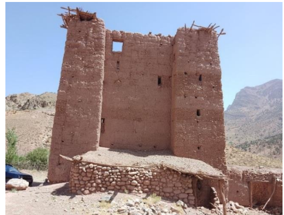
photo 12 : Ighrem de Tawsbouht sans toit
