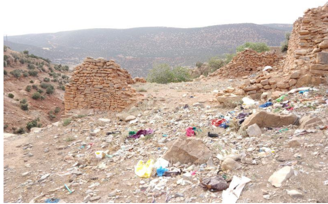
photo 16 : parties des murs d'igrem des Aâmmou
