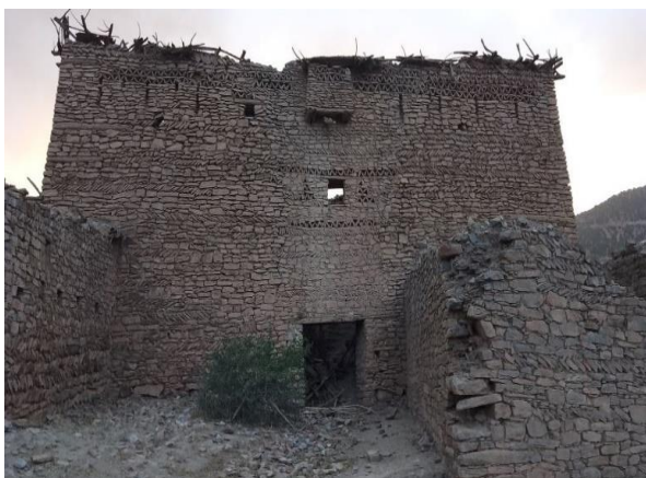
Photo 11 : Ighrem des Ayt Wouchen sans toit
