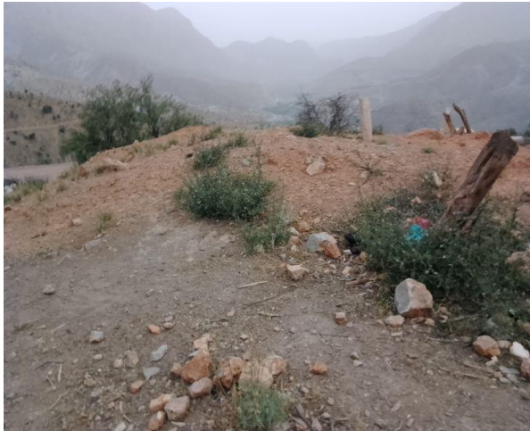
Photo 13 : Ighrem des Ayt Ali M̄ha effondré
