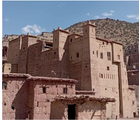
photo 21 : Tighremt transformée en gîte
