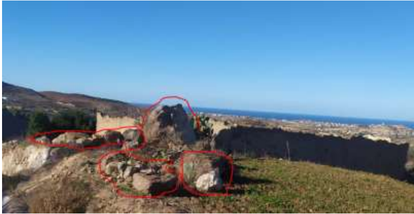
الصورة 14: مشهد من الانهيار الصخري بقدم سفح الهضاب البركانية
