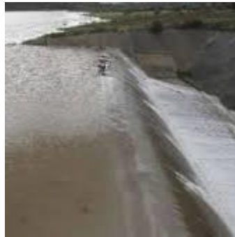
صورة (9) مفيض المياه في سد الأبرش
