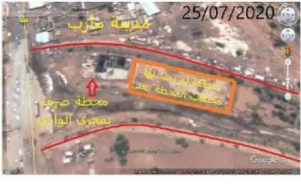
انتهاء اعمال إنشاء محطة الصرف الصحي المطارة وبدأ التشغيل في يوليو 2020
