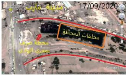
توقف محطة الصرف الصحي المطارة عن العمل وغرقها وخروج المياه الملوثة في سبتمبر 2020 (أي بعد شهرين من بدأ تشغيلها)
